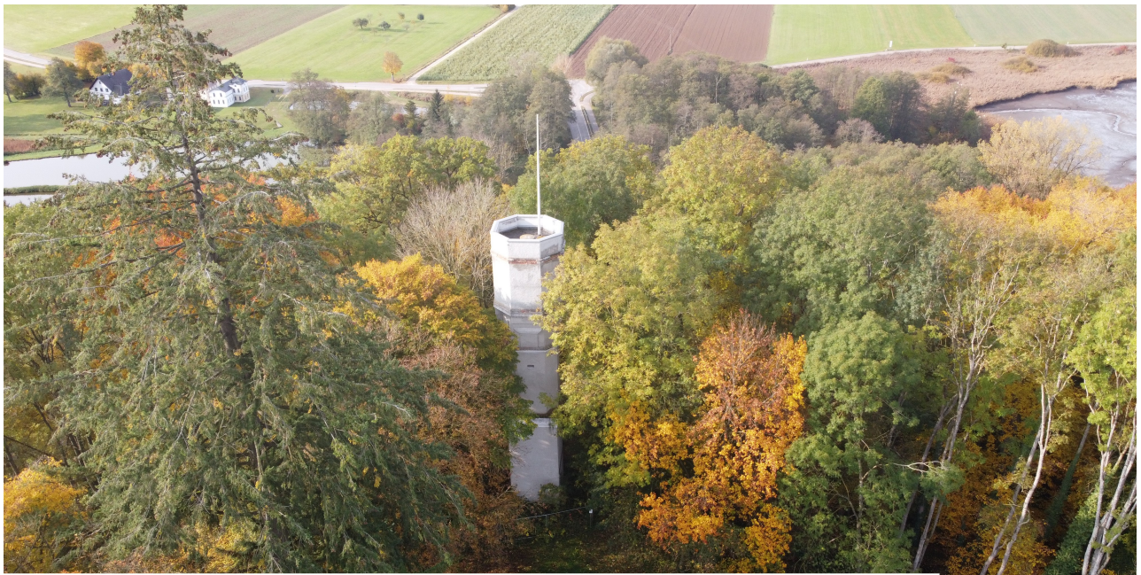
Der Wasserturm von Osten aus.
