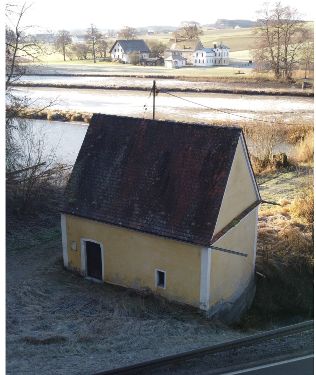
Das Radhaus, im Hintergrund die Turmuhrenfabrik Pechmann
