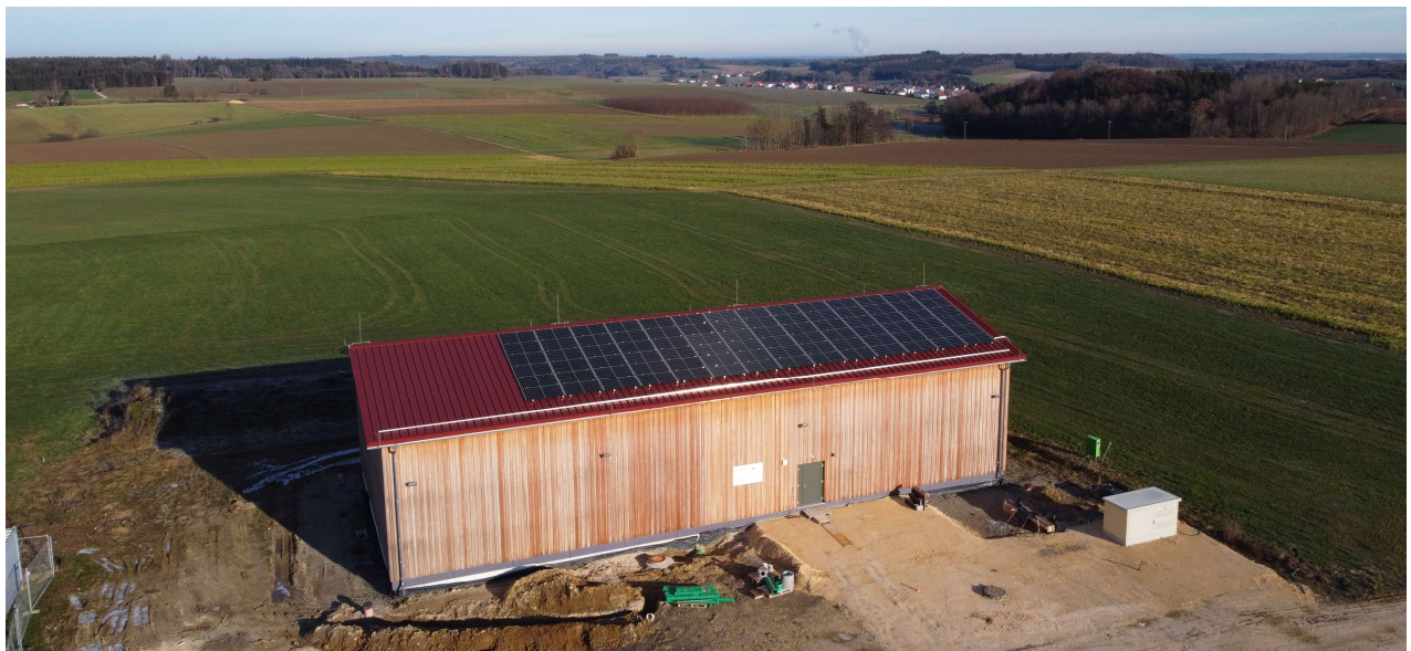
Das neue Wasserwerk kurz vor der Fertigstellung am „Eichet“, Schleebacher-Weg, zwischen Staatsstraße 2019 und Schleebuch
